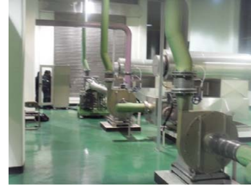
更换之前的热分解式臭氧破坏器 (370 °C)
