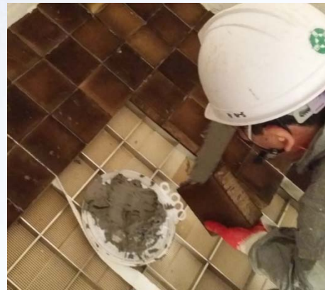
安放耐高温长寿命触媒 (模块)
